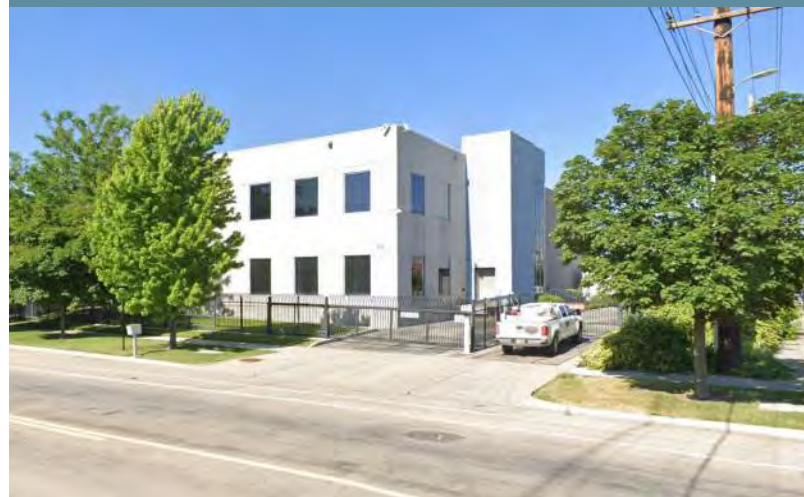
3. DATA CENTER - FLEXENTIAL
