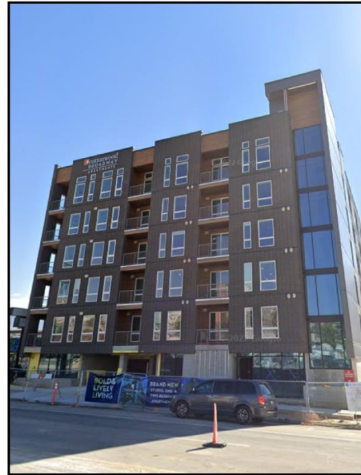
325 E 300 S - Broadway apartments BLD2018-06568/PLNPCM2018-00390
