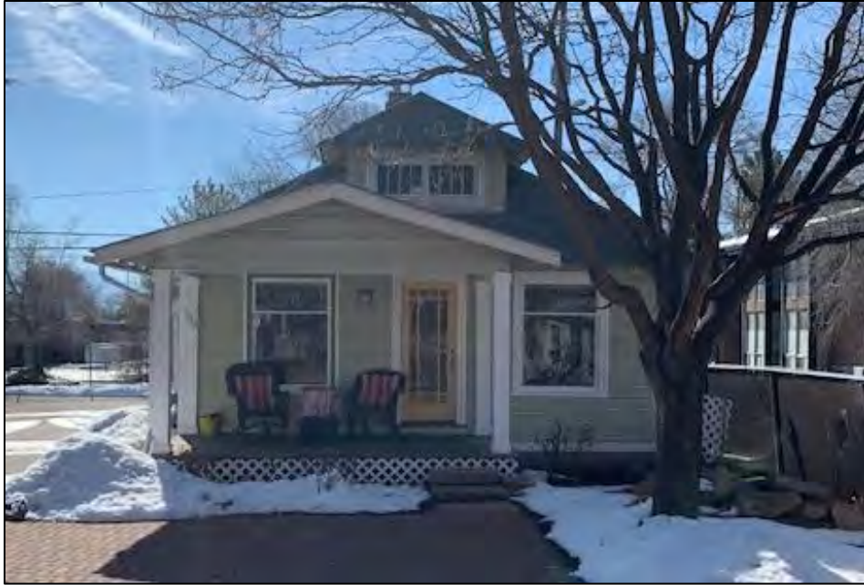
North Elevation of 732 E. 200 S.
