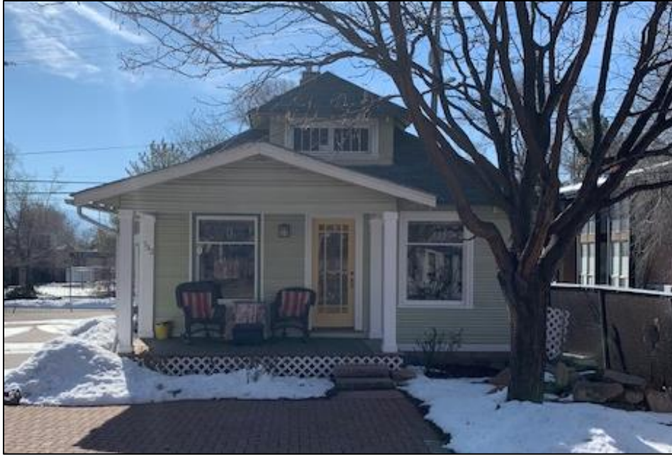
North Elevation of 732 E. 200 S.
