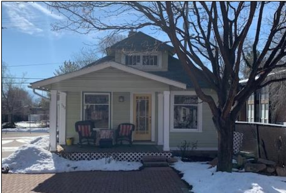
North Elevation of 732 E. 200 S.
