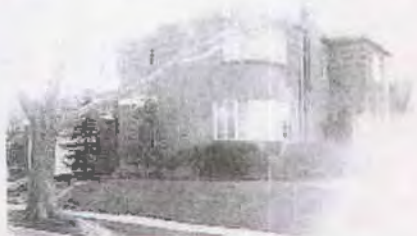
1308 E. Laird Ave. Built : 1939 Art Moderne
