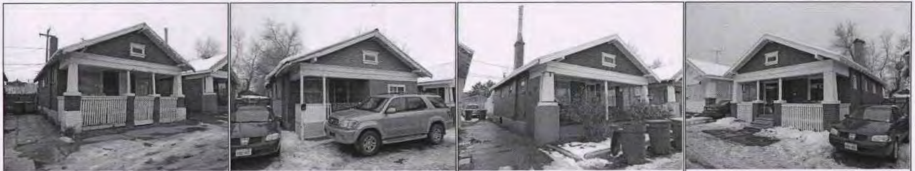
521 E. HAWTHORNE AVE. EC 522 E. HAWTHORNE AVE. EC 525 E. HAWTHORNE AVE. EC 526 E. HAWTHORNE AVE. EC
