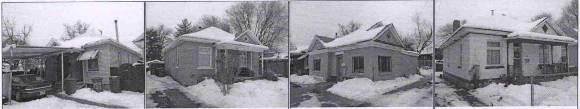
759 S. KILBOURNE CT. NC 760 S. KILBOURNE CT. EC 763 S. KILBOURNE CT. EC 764 S. KILBOURNE CT. EC
