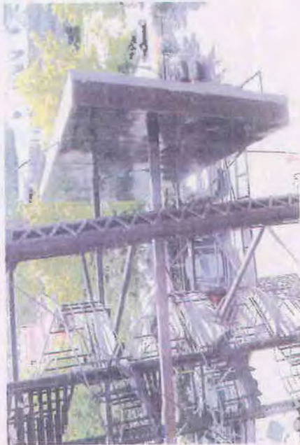
A4 EXISTING MARQUEE SUPPORT SCALE: NONE
