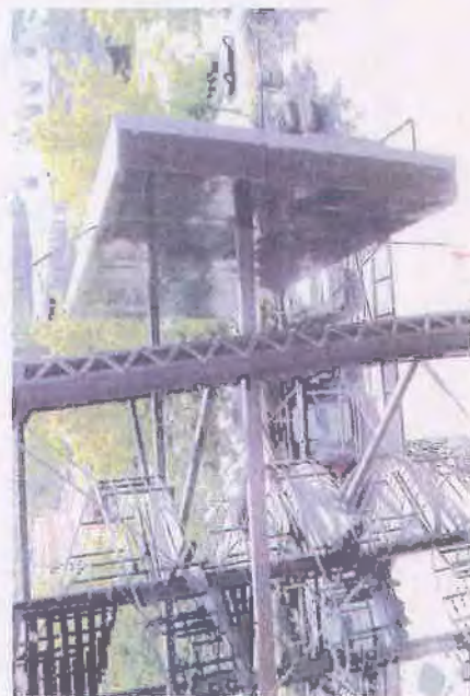
A4 EXISTING MARQUEE SUPPORT SCALE: NONE
